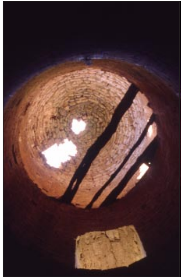
Interior de la torre. Fotografia de Jordi Gironès
