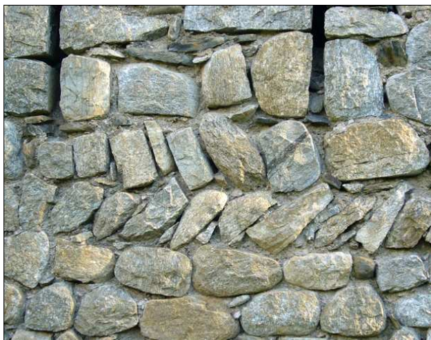
Opus spicatum a les parets de l'edifici.
