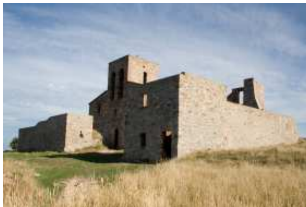
L'església de Santa Maria de Tagamanent ha estat restaurada recentment junt amb els edificis adjacents.
