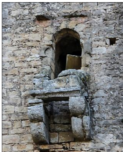
Matacà amb arc de mig punt.
